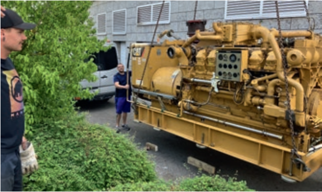
Ausbringung des alten BHKW und Einbringung des neuen.
